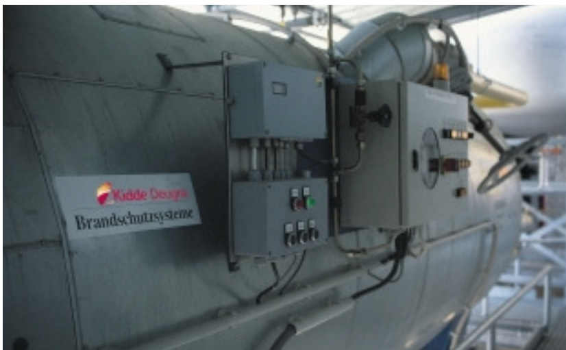
CO 2 - Zbiornik CO 2 z elektronicznym układem ważącym
