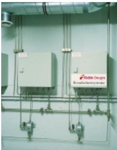
Układ opóźniaczy pneumatycznych
